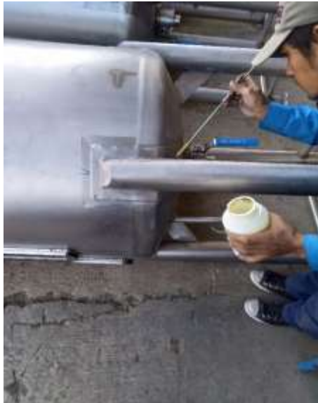
Gambar 15 Pengolesan pickling gel
