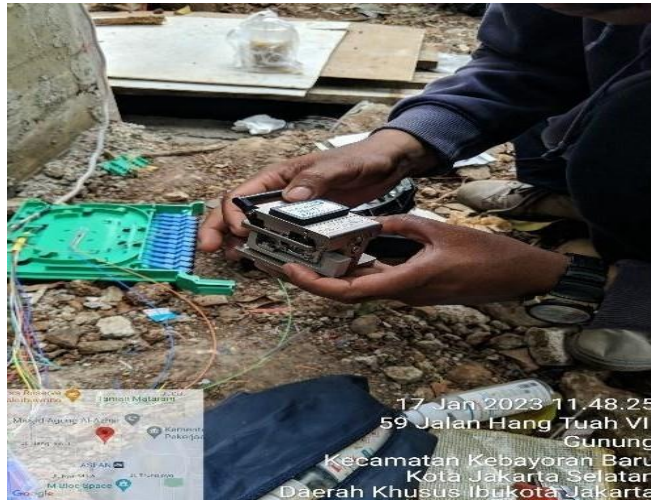
Gambar Pemotongan serat menggunakan cleaver
