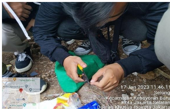
Gambar Pengupasan coating menggunakan stripper
