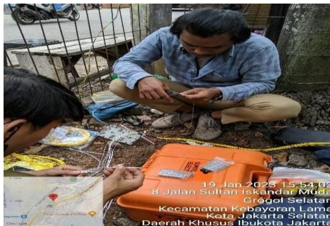
Gambar Fusion Splicer Memasang sleeve (pelindung sambungan)
