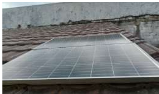
Gambar 2. Dua Buah Panel Surya Monokristalin Maysun Singled 120 WP yang Dirangkai Seri Menjadi Total 240 WP
