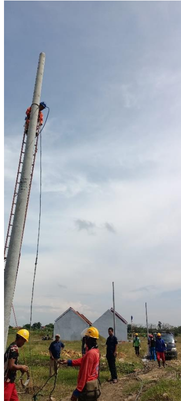
Gambar 2. Pemasangan Tiang beton
