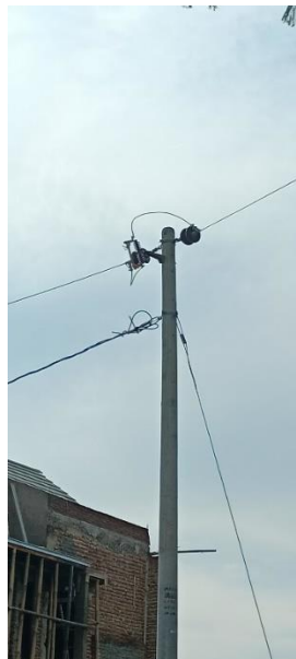
Gambar 5. FCO posisi sudah terpasang dan sudah berkordinasi. Penyelesaian Akhir ( finishing )
