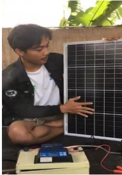
Gambar 9 perakitan panel surya ke komponen
