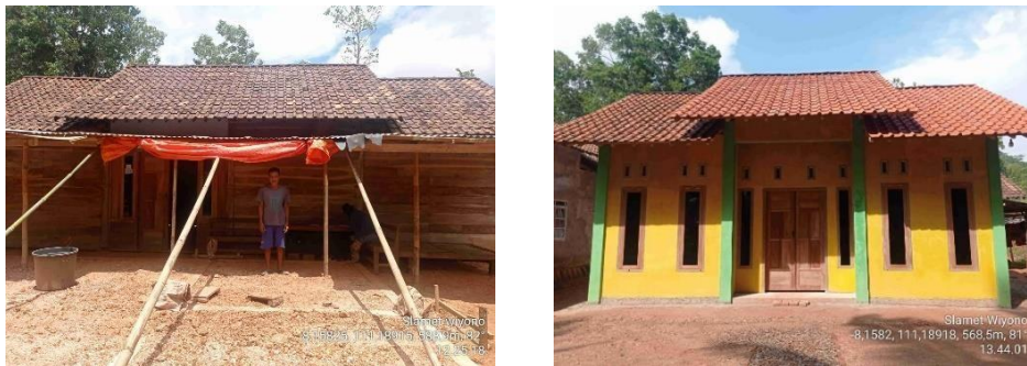
Gambar 1 Rumah Sebelum dan Sesudah Pembangunan
