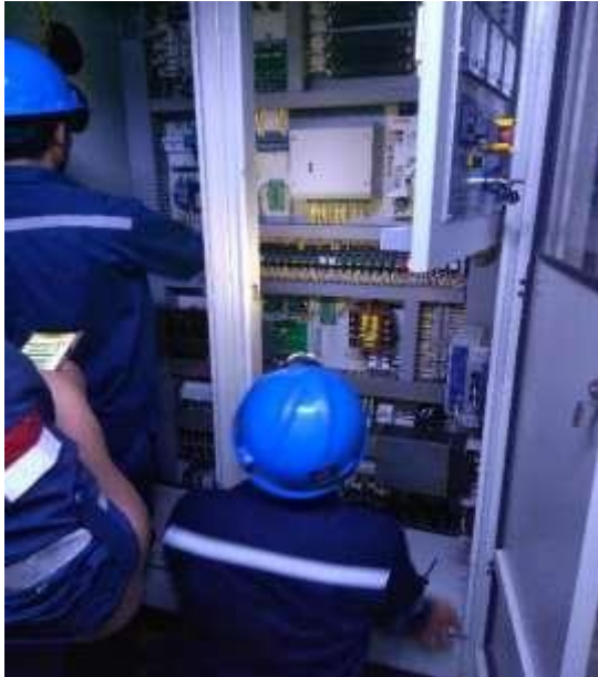
Gambar 4.2 Pemasangan Thyristor Blok Setting ABB UNITROL 1020 Generator
