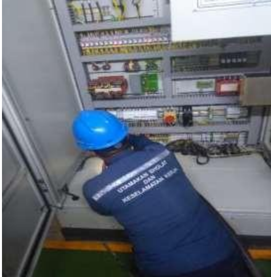
Gambar 1. Pemeliharaan Panel Kontrol AVR
