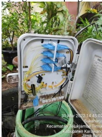
Gambar 20 Proses validasi odp panel pedestal di lapangan.
