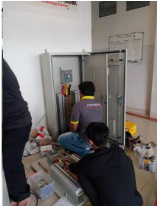
Gambar 5. Pemasangan Komponen Panel LVMDP
