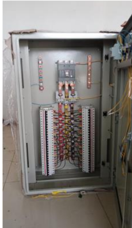
Gambar 6. Pemasangan Komponen Panel LVMDP
