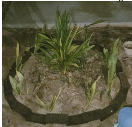
Gambar 5. Penempatan Paving Block di Taman Posyandu
