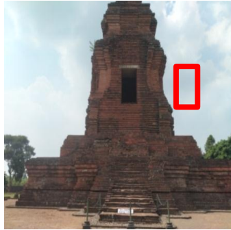
Gambar 1. Bagian Pintu Candi Brahu
