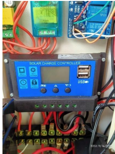
Gambar 21. Pemasangan Kabel Pada Solar Charger Controller (SCC)
