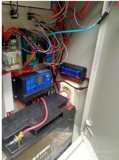
Gambar 23. Pemasangan Baterai ke dalam Panel Box
