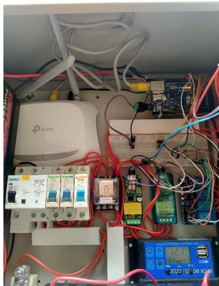
Gambar 22. Pemasangan Komponen di dalam Panel Box
