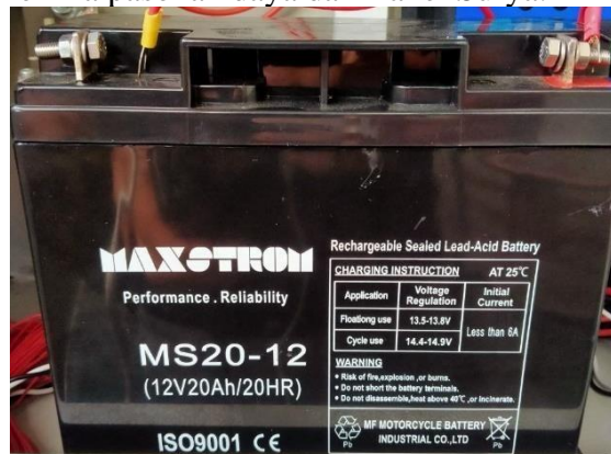
Gambar 18. Baterai 12 Volt 20 Ah
