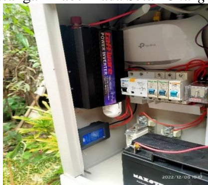
Gambar 22. Pemasangan Inverter
